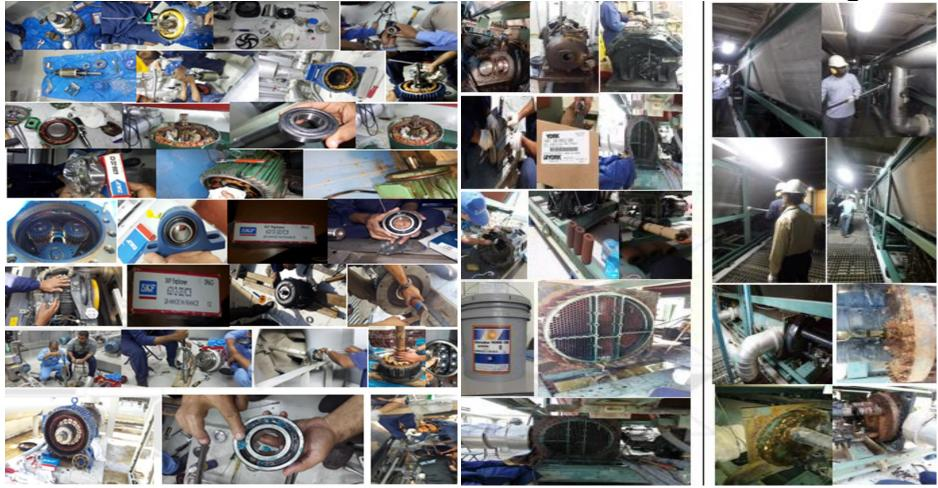
العمور: - (تغيير رمان البلي للمحركات الكهربائية الخاص بوحدات التكييف والمضخات والسلالم الكهربائية واستخدام أدوات قياس كالأفوميتر والاهتزاز لكشف حالة
